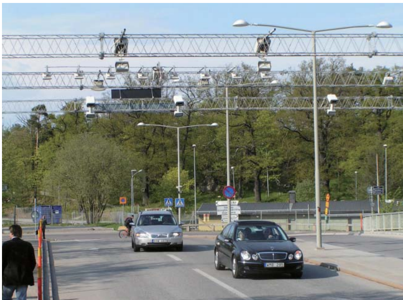
图64 道路上方的探测头控制斯德哥尔摩市的拥堵收费 (图片来源：Manfred Breithaupt, 瑞典斯德哥尔摩, 2008)
