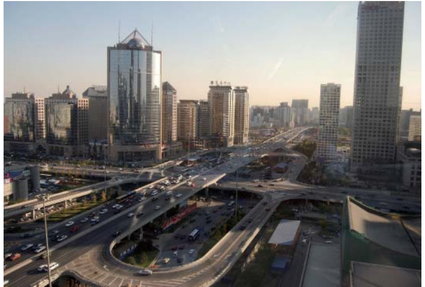
图12 北京的高架立交桥对非机动车交通形成阻碍 (图片来源: Carlosfelipe Pardo, 中国北京, 2007)
