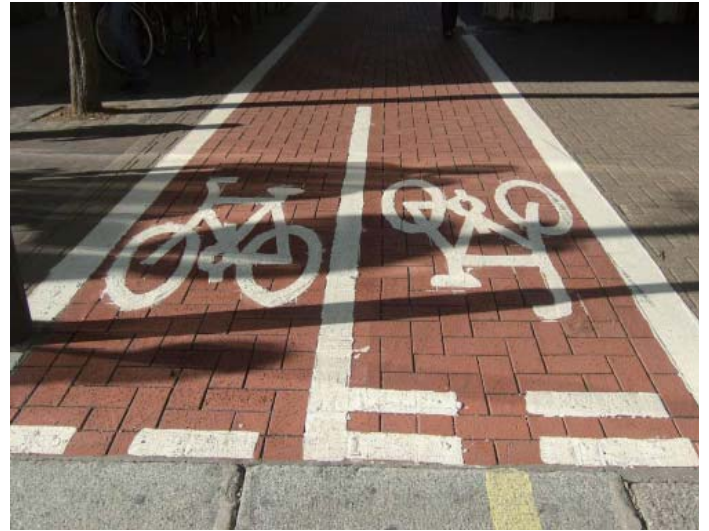
图36 伦敦一条设计良好的经过着色和纹理铺装的自行车道 (图片来源: Lloyd Wright, 英国伦敦, 2006)
