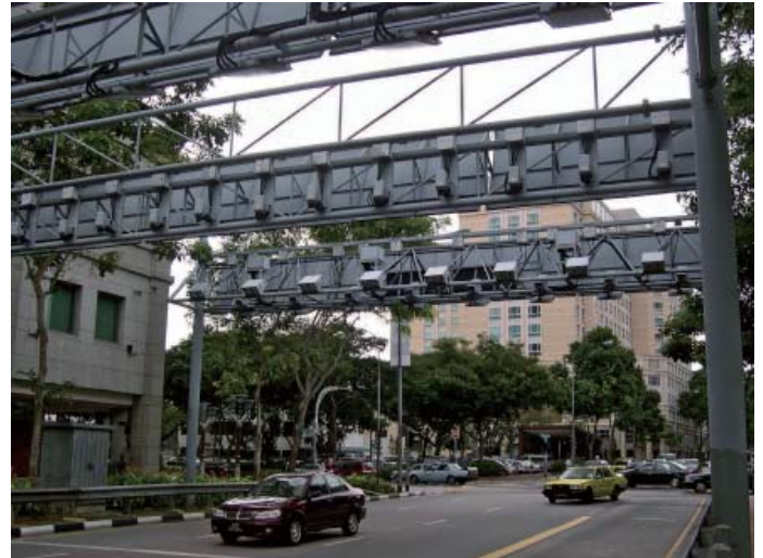
图66 短距离无线电通讯系统被用于从智能卡上自动扣除道路使用费 (图片来源: Manfred Breithaupt, 新加坡, 2003)
