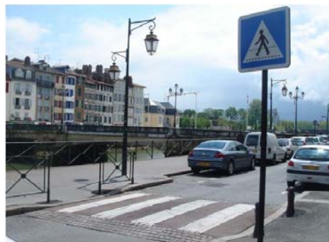
Hình 33: Đoạn thắt cổ chai, báo hiệu và mô giảm tốc đảm bảo giảm tốc độ của xe con (Bayonne)
