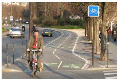
Hình 39: Đường xe đạp 2 chiều được tách biệt ở Pari
