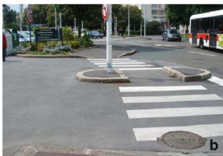
Hình 31b: Vạch sang đường này cung cấp một điểm dừng chân cho người đi bộ khi băng qua một con đường rộng
