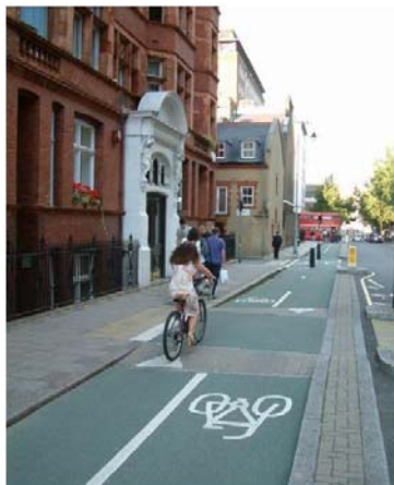
Hình 38: Đường dành cho xe đạp có 2 chiều được tách biệt với đường phố ở Luân Đôn
