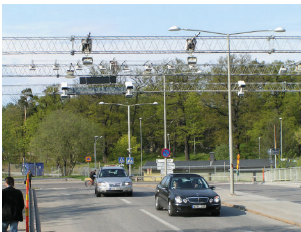
Figure 56 : Les points de contrôle des péages urbains fournissent des données utiles pour la planification et l'évaluation des politiques, Stockholm. Source : Manfred Breithaupt, 2006.
