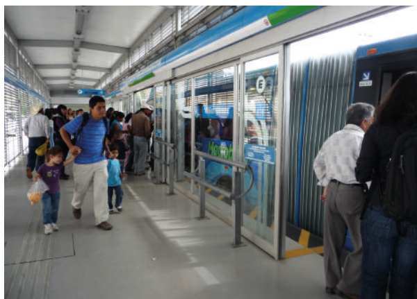
Figure 29 : Accès sans obstacle au bus BHNS à Mexico City.
