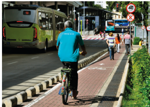
Figure 25 : Nouvelle piste cyclable à côté du système BHNS de Belo Horizonte « MOVE » (Brésil). Source : EMBARQ Brésil, 2014.
