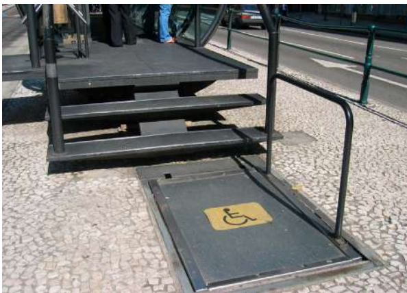
Мал. 42. Технічне рішення безбар'єрного доступу до станції експрес-автобусу в Курітібі, Бразилія.
