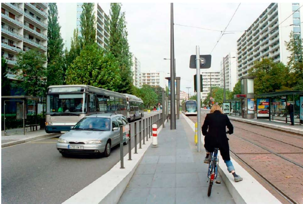
Мал. 39. Станція пересадки міського рейкового та автобусного транспорту у Страсбурзі.
