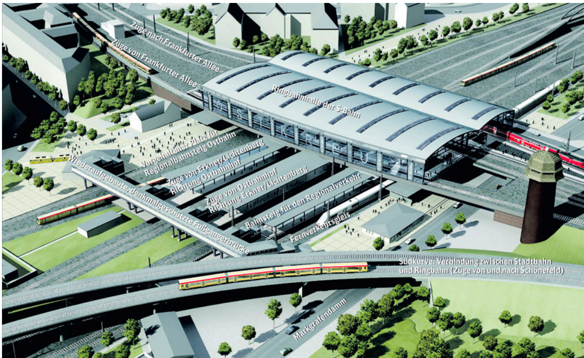
Figure 40: Multi-level metro-suburban train station (Berlin Ostkreuz). Source: http://www.s-bahn-berlin.de/aktuell/2007/images/047_ostkreuz_aufbau_gross.jpg
