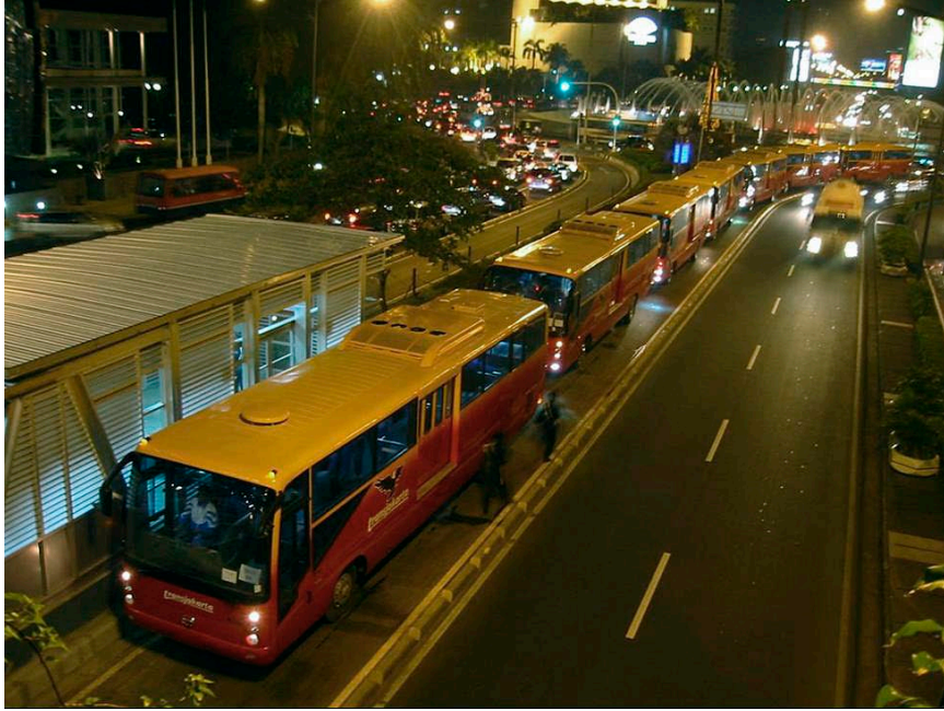
Fig. 18 TransJakarta BRT system.
