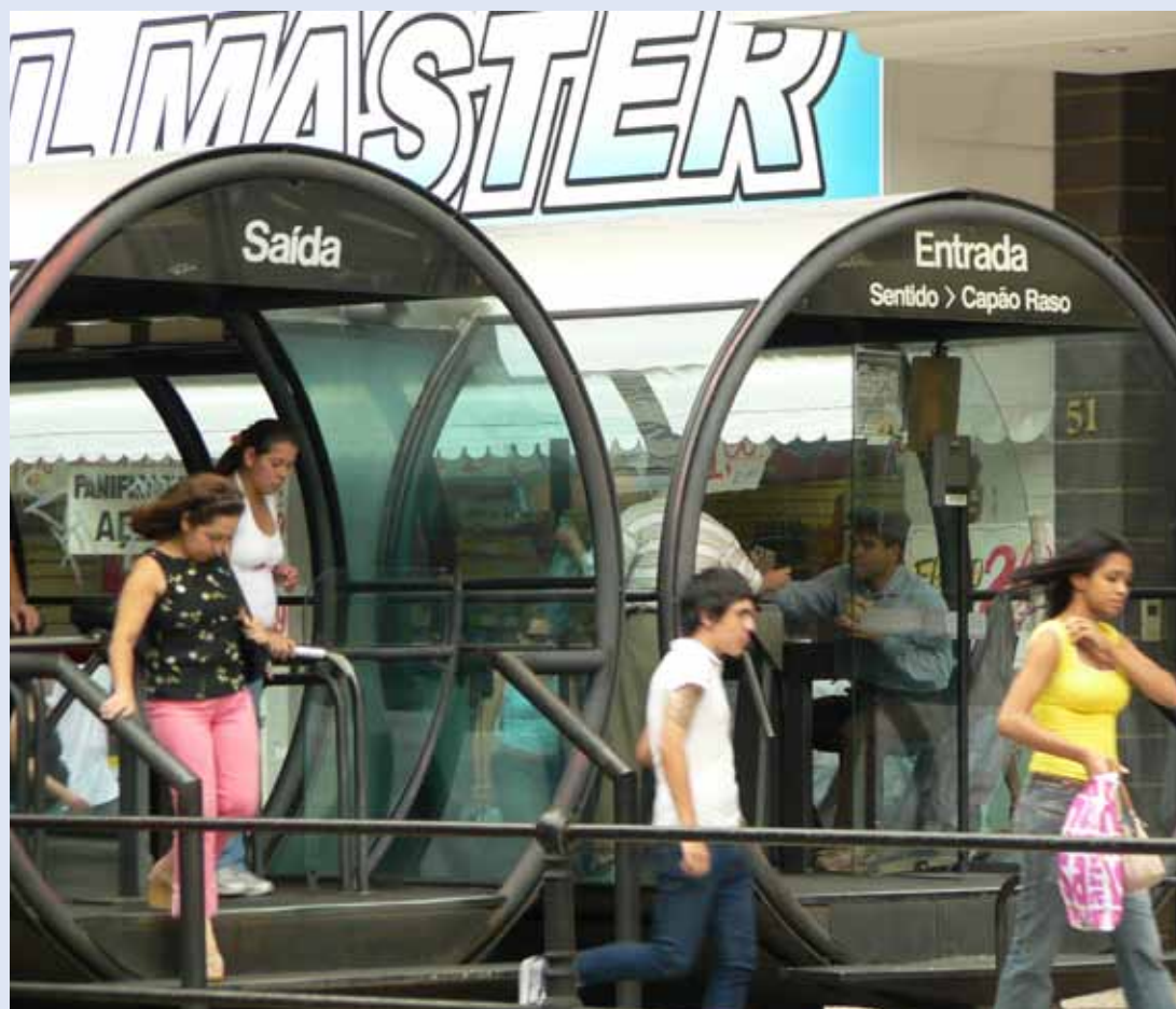
Станция системы скоростных автобусных перевозок (БРТ) в г. Куритиба, Бразилия, с которой пассажиры попадают прямо в городской центр.
