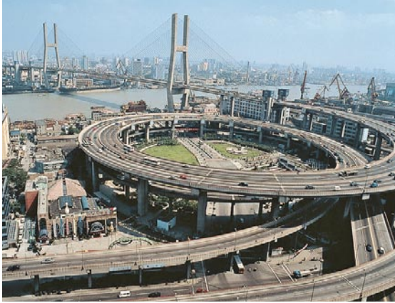
Fig. 2 Puente Nanpu, Shanghai, China. Las grandes carreteras son todavía vistas como símbolos de progreso y modernidad en ciudades en desarrollo. Algunas de las ciudades más ricas – como San Diego – han, por el contrario, eliminado las carreteras elevadas dentro de las ciudades y han interrumpido la expansión de las carreteras.
