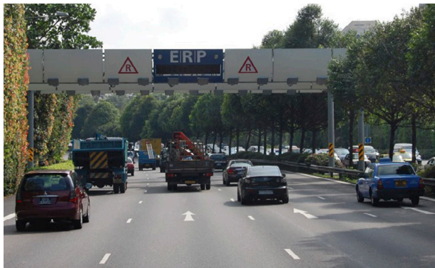
Fig. 22a, b Portique électronique de péage urbain (à gauche) et système de taxation embarqué (à droite) à Singapour.
