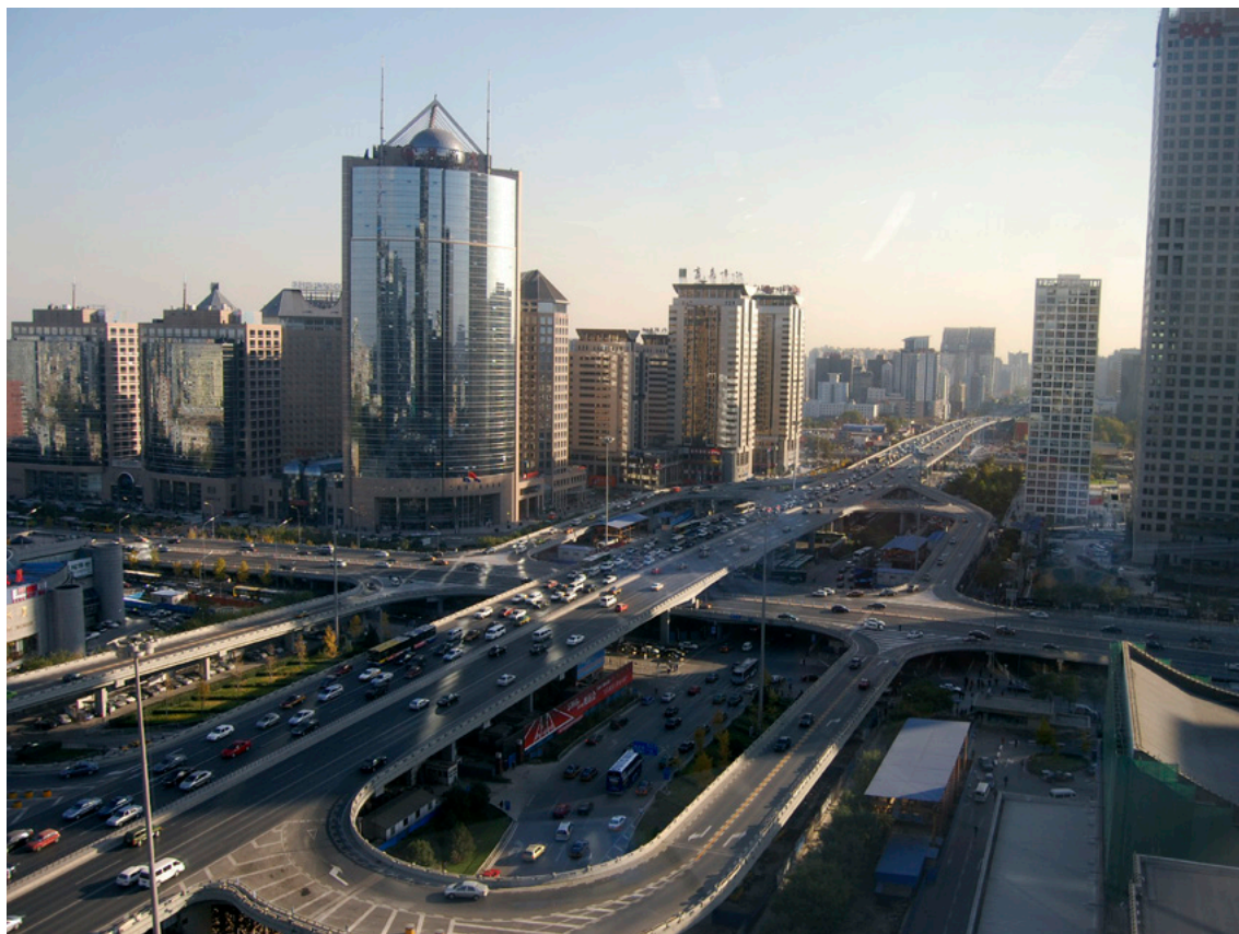
Fig. 12 Autoroutes urbaines financées par des bailleurs de fonds étrangers à Pékin, Chine.
