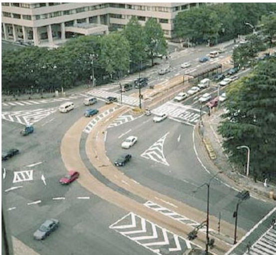
Fig. 9 Nagoya, Japón, demarca los carriles de autobuses con una superficie de vía coloreada.
