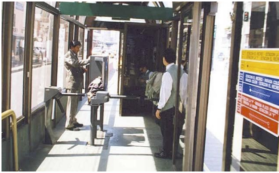
Fig. 27 Estación de BRT en Quito, Ecuador: US$ 35.000
