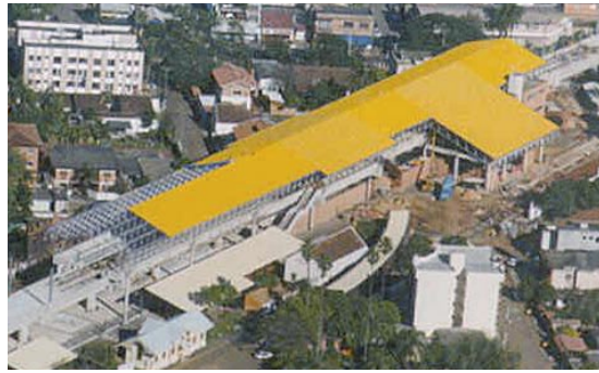
Fig. 28 Estación de tren en Porto Alegre: US$ 150 millones
