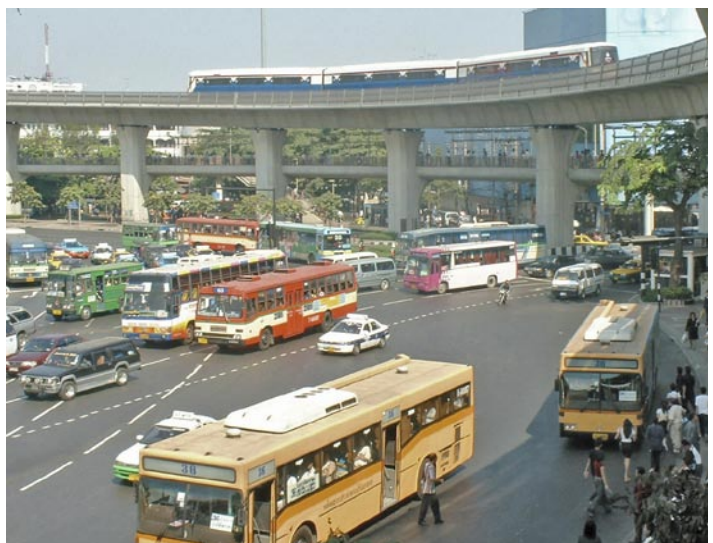
Hình 21: Công trình Victory, Băng Kốc. Các đoàn tàu BTS chạy trên các đường đôi, trên một cầu cạn rộng 9m được đỡ bằng các dầm cầu vượt hộp đơn, mỗi dầm cầu cao cách mặt đất 12m Karl Fjellstrom, tháng 2/2002
