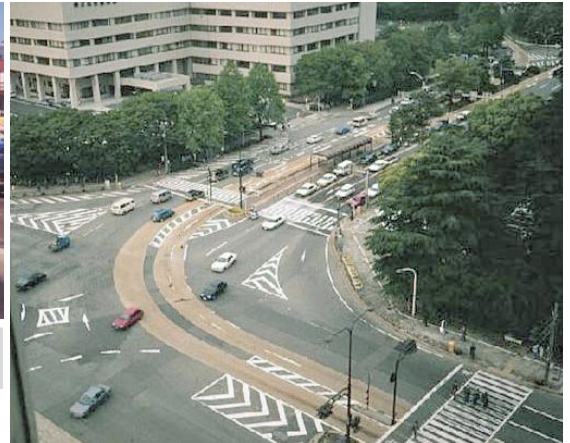
Hình 9: Nagoya, Nhật Bản đánh dấu các làn đường dành cho xe buýt với mặt đường bằng màu
