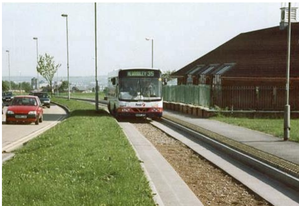
Hình 13: Ipswich, Anh. Dải giữa đường không trải mặt làm giảm đáng kể chi phí, và cũng làm giảm tiếng ồn. Ảnh của John Marino (Irisbus) và Ban Nghiên cứu GTVT Mỹ
