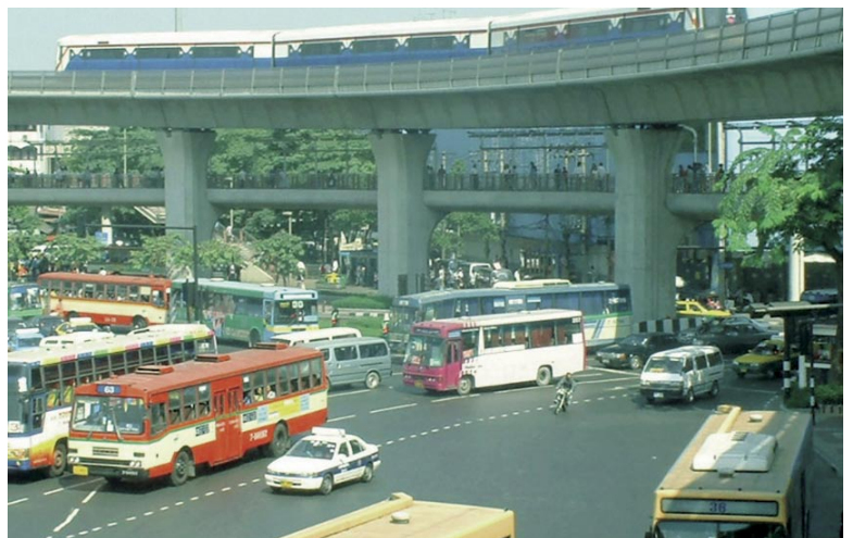
图 21： 曼谷的胜利碑。BTS 列车沿着双向轨道运行，轨道设置在 9 m 宽的高架桥上，支架为单箱结构的高架桥梁，每个梁高于地面 12m。 (Karl Fjellstrom 于 2002 年 1 月)
