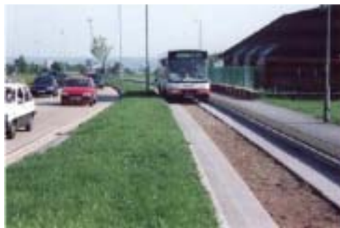
△▷<그림14> BRT 차로의 중앙부분 미포장은 실질적인 비용절감과 소음감소를 가져옴
