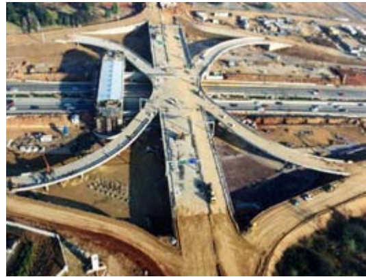
图 90 南非 Midrand 的公路建设大量采用机械设备而不是人力作业 (摄影: Lloyd Wright)
