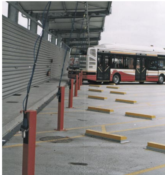
Fig. 2-7 Estación de llenado lento en Poitiers, Francia.
