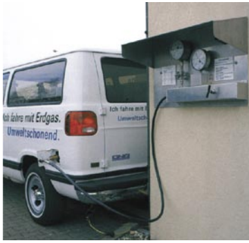
Fig. 2-1 Estación de llenado rápido en Rubrgas en Dorsten. Ruhrgas AG
