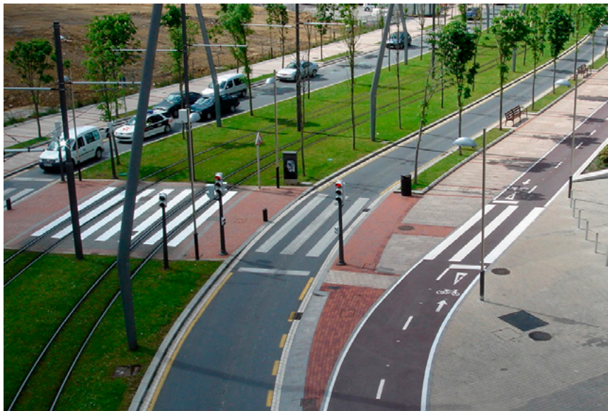
Fig. 10 Quatre modes, quatre espaces de circulation : la séparation des modes de transport (tramway, trafic motorisé, piétons et cycles).
