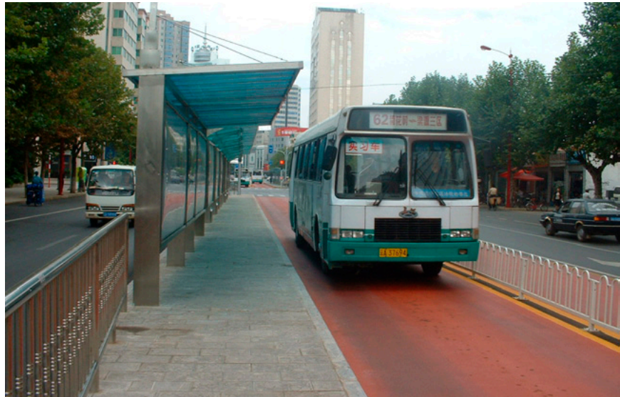
Fig. 17 Paradero de buses en una estación del corredor del BRT en Kunming.
