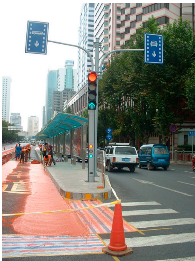
Figura 30: O BRT em Kunming: faixas de BRT estão sendo pintadas de vermelho.
