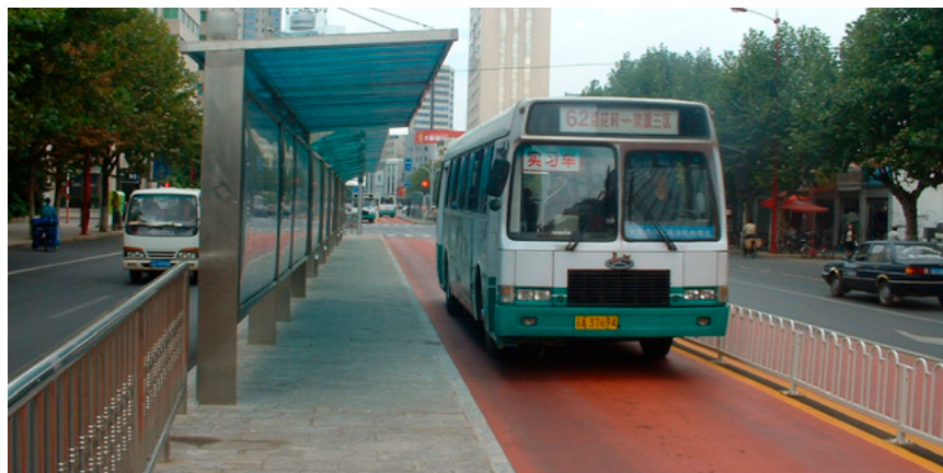
图17 昆明快速公交线路上的公交车站 Karl Fellstorm拍摄 昆明 2003
