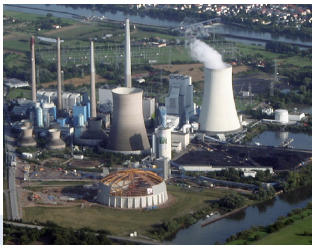
Figura 51: La electricidad generada por centrales eléctricas de carbón reduce significativamente los beneficios del clima de los vehículos eléctricos. Una central eléctrica de carbón cerca de Hanau, Alemania.
