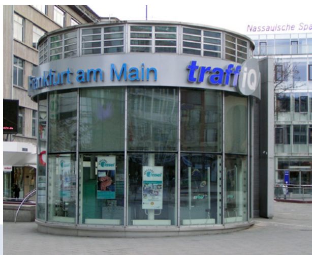
Figura 17: Departamento local de transportes, Frankfurt am Main, Alemanha. Fonte: Armin Wagner, 2006
