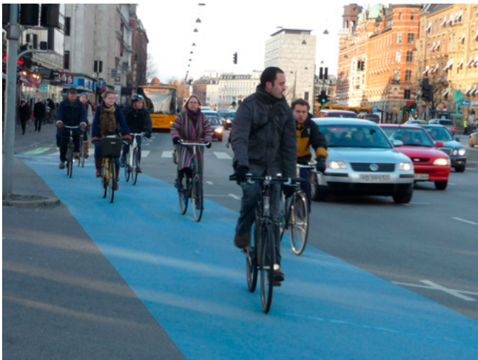
图54: 道路交叉口的彩绘自行车车道,是哥本哈根知名的提高自行车道可视性的有效措施,来源: Manfred Breithaupt, 2009年
