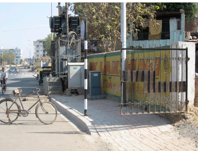
Figura 32: A infraestrutura inapropriada para pedestres e ciclistas deve ser abordada pelos Planos de Mobilidade Urbana; Ahmedabad (Índia). © Christopher Kost, 2014
