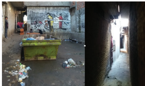
Figura 21: Malas condiciones para caminar en un barrio bajo en Buenos Aires: escalones empinados, contaminación con basura y pasajes angostos, que no permiten moverse fácilmente llevando cargas y crean espacios aterradoras, incluso con luz de día. Fotos de Laura Mark.
