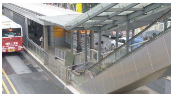
Figura 13: Escaleras mecánicas no funcionan en una estación de BRT. Foto de Heather Allen.
